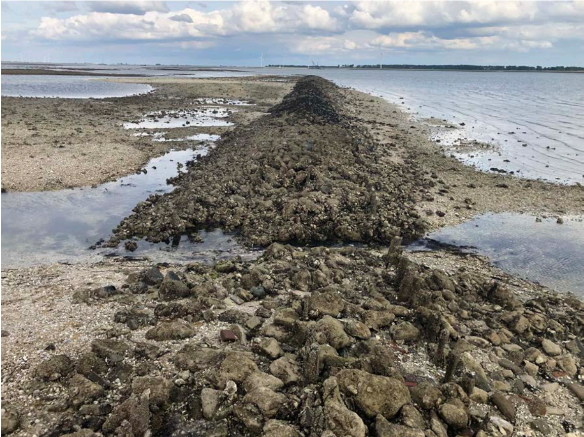
De havendam is op verschillende plekken geërodeerd (foto Buro Waterfront)
