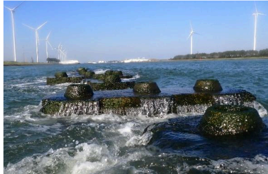
Figuur 1 Reef Enhancing Breakwater toegepast in the Rotterdam Reef project, ecologische monitoring en de nieuwste update van ReefBlock.
